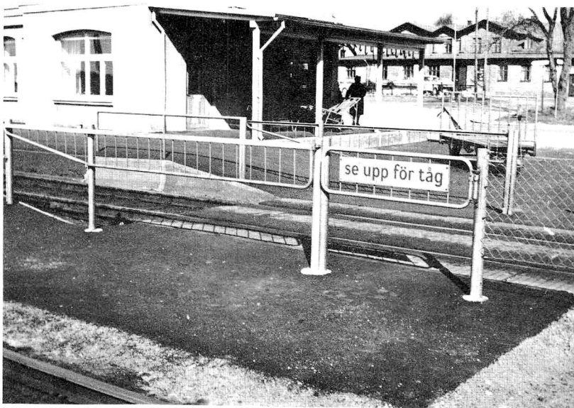
Fig 189 Gånggrind med varningsskylt samt skjutgrind
