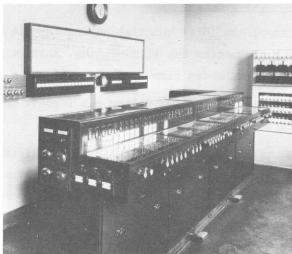
Fig 122 Elektriskt ställverk med mekaniskt låsregister
