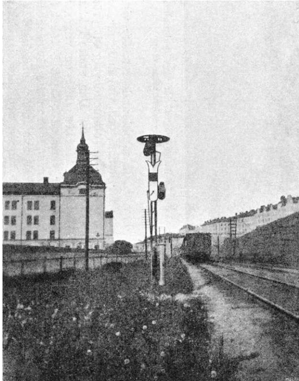
Bild 70 B. Huvudsignalen visar kör för huvudtågväg.
