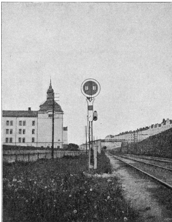
Bild 76 A. Försignal för tågvägssignalering. Huvudsignalen visar stopp.
