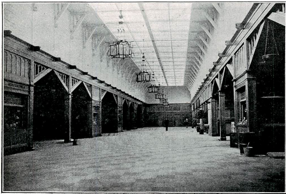
Fig. 2. Vänthallen mot väster.
