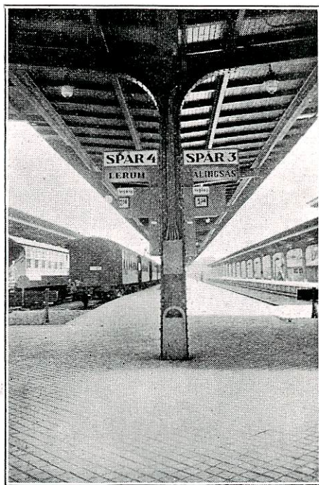
Fig. 5. Plattformstak och tågvisare.
