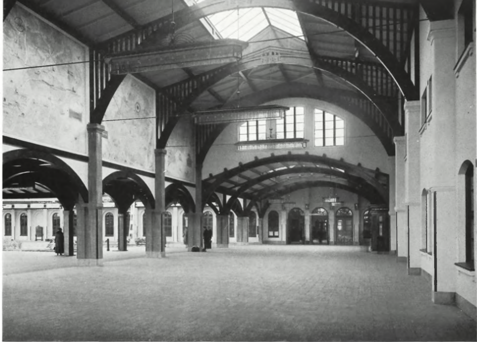
Stamplattformen för avgående tåg med tågplattformarna till vänster och expeditionsbyggnaden till höger 1930
