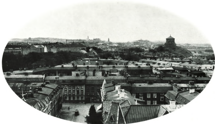
Utsikt från Redbergslid 1930
