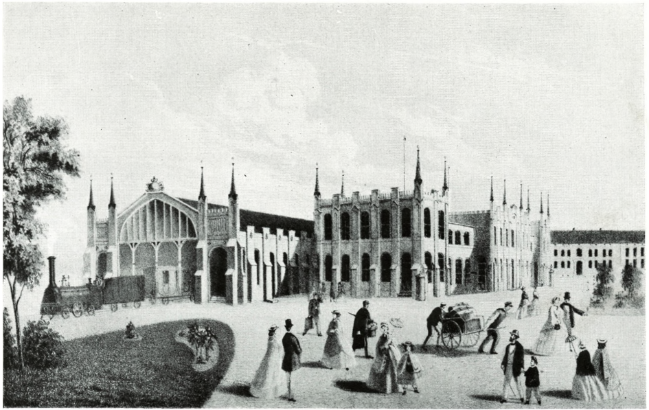
Stationshuset från väster 1859
