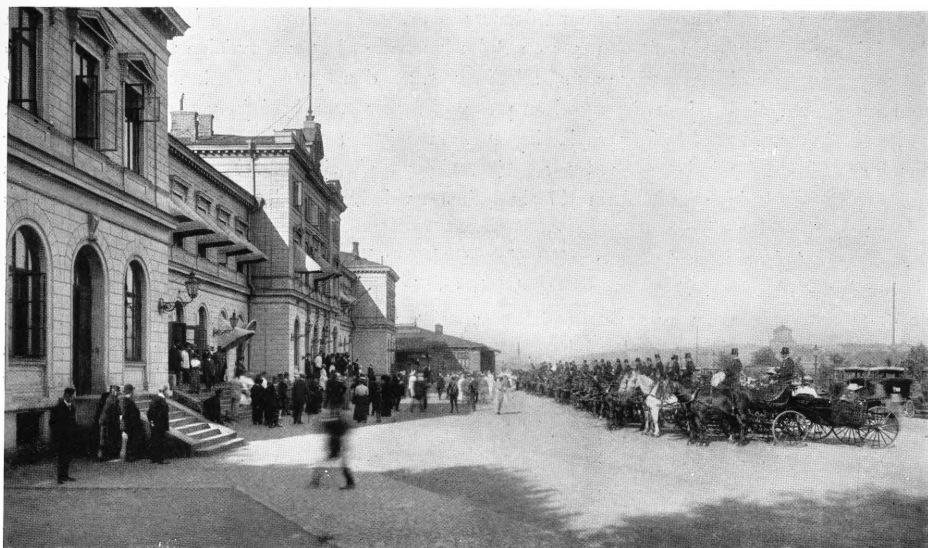
Bergslagsbanans stationshus omkring 1900
