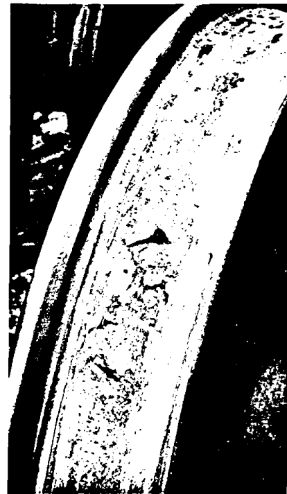
Bild 3. Sårskada på hjul efter utmattning av materialet
