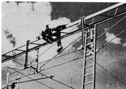
Fig 4. Skadad person i beröring med intakt högspanningsanläggning
