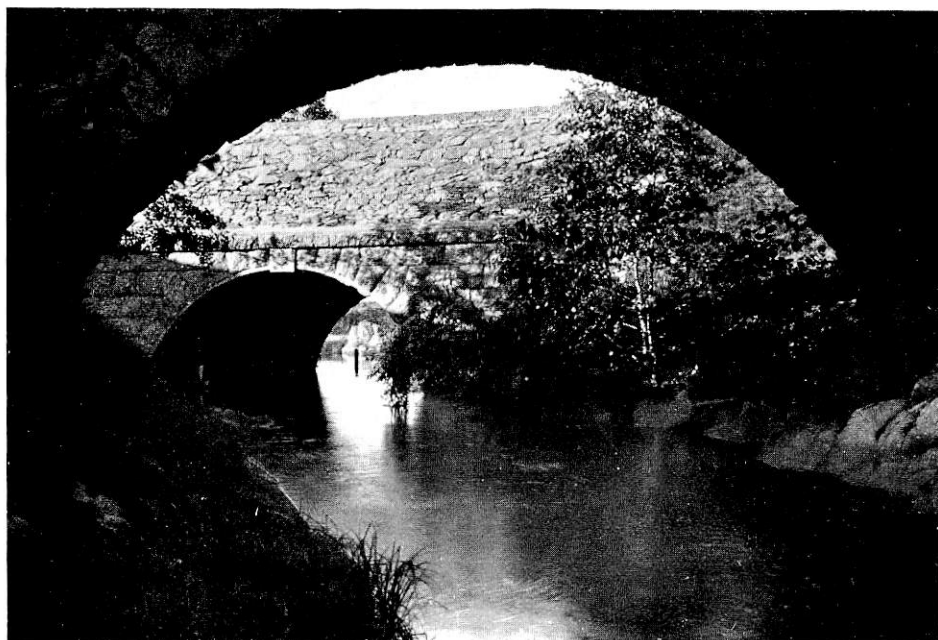
Kulvert över Stångån vid Rimforsa.
