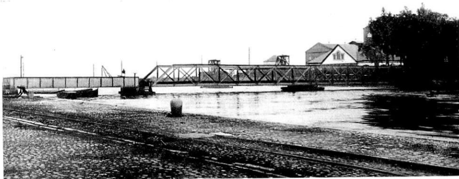
Järnvägsbron i Lidköping.
