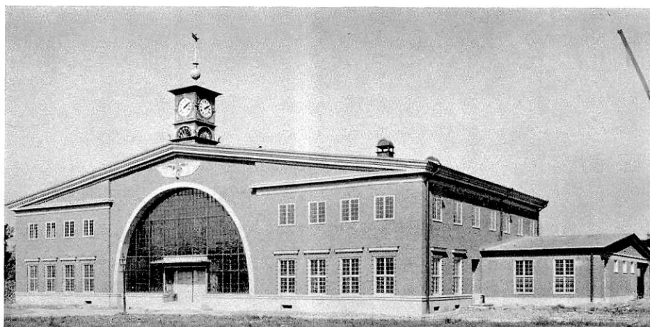
Gävle södra stationshus under uppförande år 1926.
