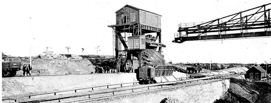
Oxelösund, vagnvändare för malmlossning. Kapacitet omkr. 500 ton i timmen.
