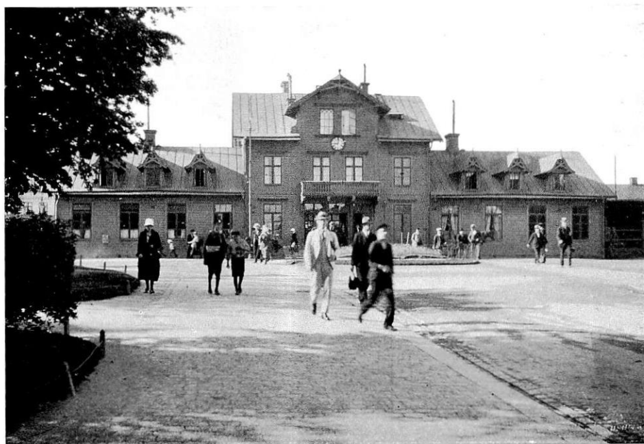
Eskilstuna gamla centralstation.
