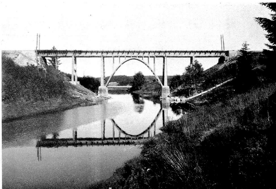
Bron över Nåsån efter förstärkningen.
