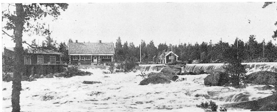
Fröseke station vid Alsterån.
