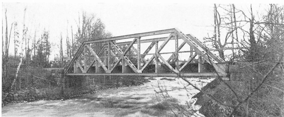
Järnvägsbron över Emån.
