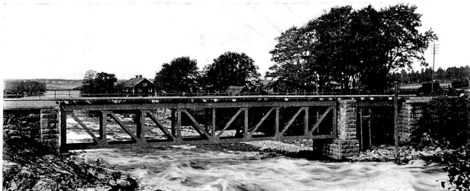
Bron över Gullspångsälven vid Gullspång.
