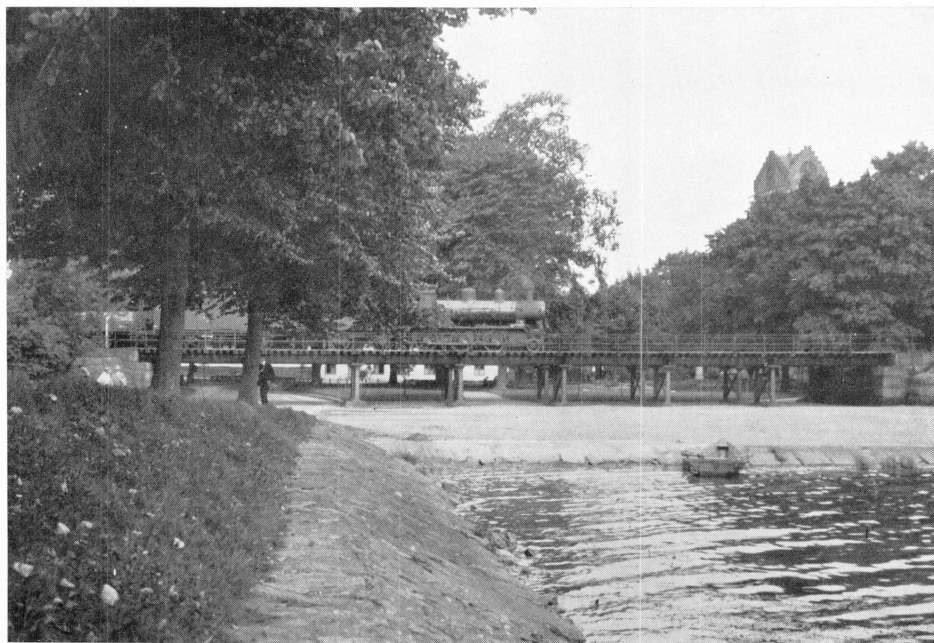
Viadukten vid Växjö.
