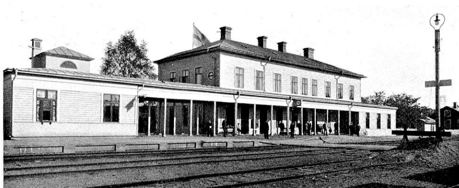
Härnösands station efter ombyggnaden år 1925.
