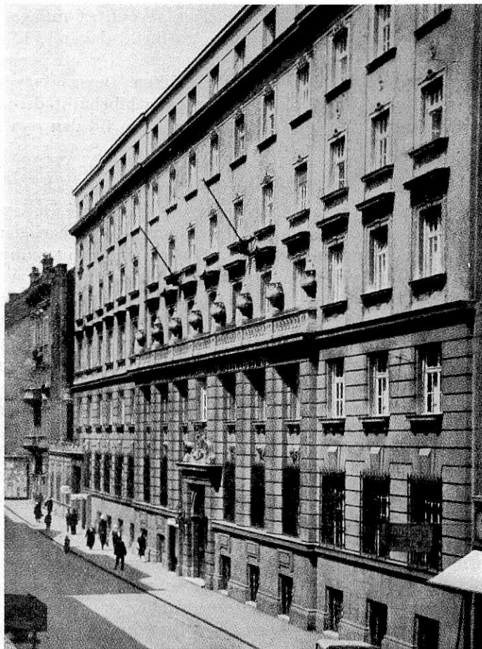
Spårvägsförvaltningens hus vid Akacfa utca.
