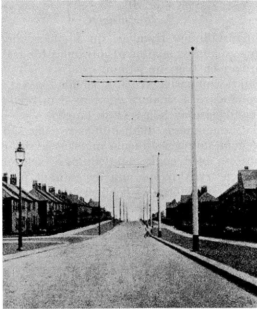
Bild 25. Enkel stolpe och utliggare. Användes ofta vid enkla linjer samt vid dubbla linjer där gatubreddens ej överstiger 8 meter.
