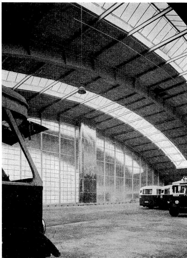
Fig. 21. Interiör från nya garaget med ventilationstrumma för golvutsugningen.
