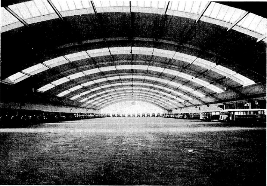
Bussgaraget vid Hornsberg. — Interiör av uppställningshallen.
