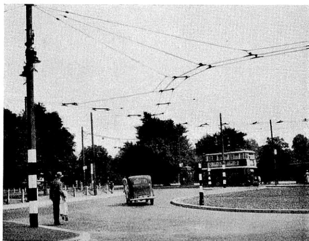
Kontaktledning vid knutpunkt.
