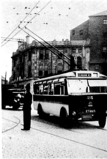
Fig. 23. Rotherham, snäv kurva i gatukorsning med kontaktledning för såväl trolleybuss- som spårvägsdrift.
