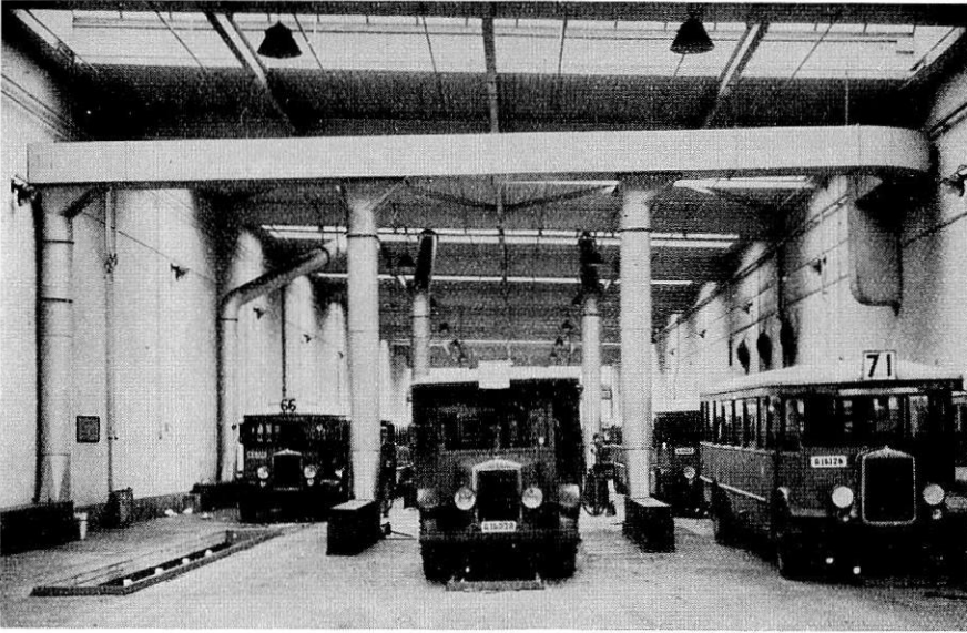
Fig. 19. Anordning för utsugning av avgaser vid körning med motorerna över smörj- och revisionsgroparna.
