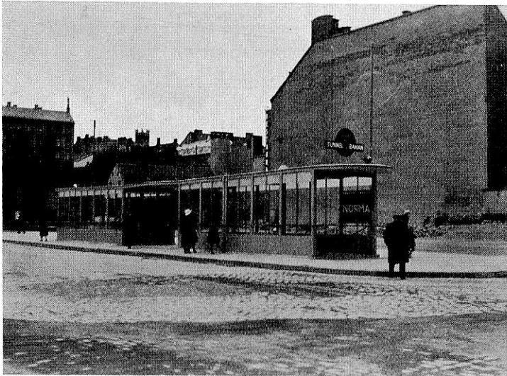
Fig. 8. Station S:t Bantorget, exteriör.
