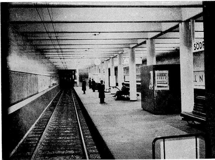
Fig. 10. Station S:a Bantorget, plattform med kiosker.
