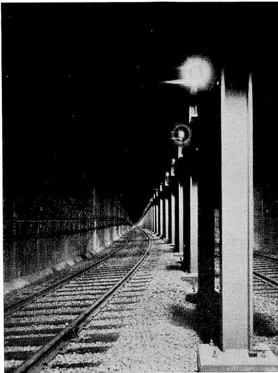
Fig. 21. Parti av betongtunneln med belysning.
