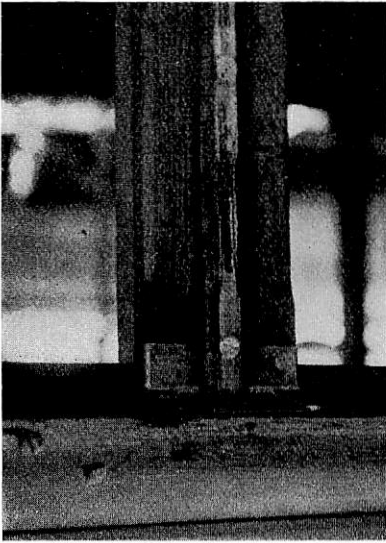
Fig. 23. Plåtskoning på korgsidostolpe vid fönsterbleck.
