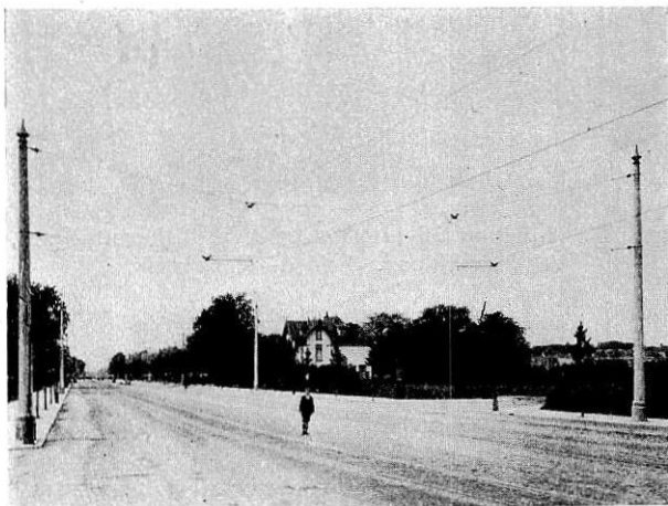
Fig. 21. Stödupphängning medelst 2 tvärtrådar. Delft— Haag—Leiden.
