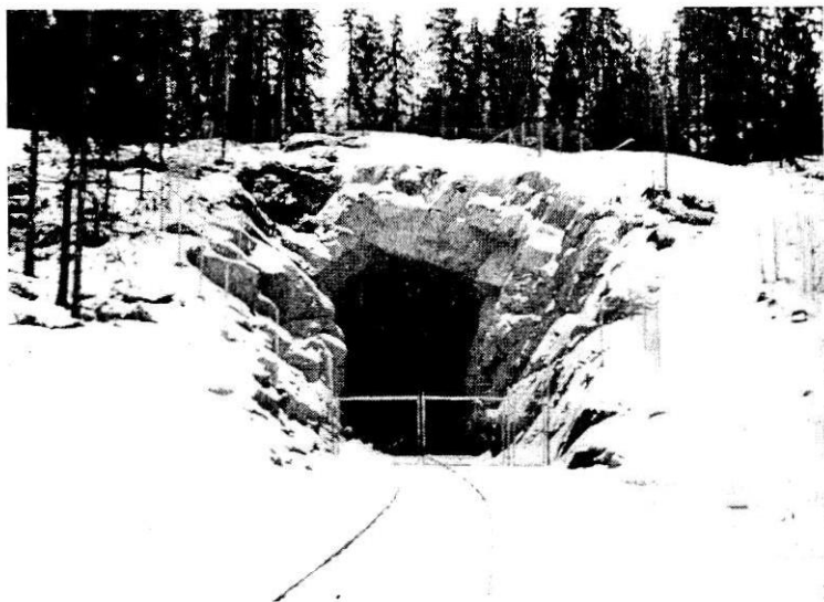
Fig. 9. Omformarstationen sedd utifrån.
