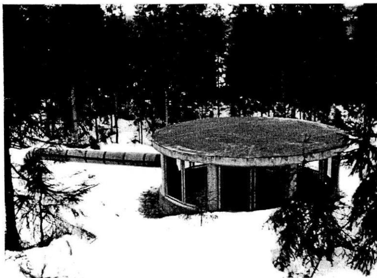
Fig. 8. Betongtak ovanför omformarstationens stigort.
