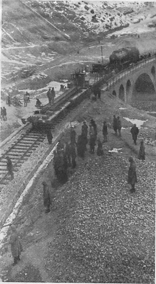
Bild 9. Schienenlegung bei km 215.
