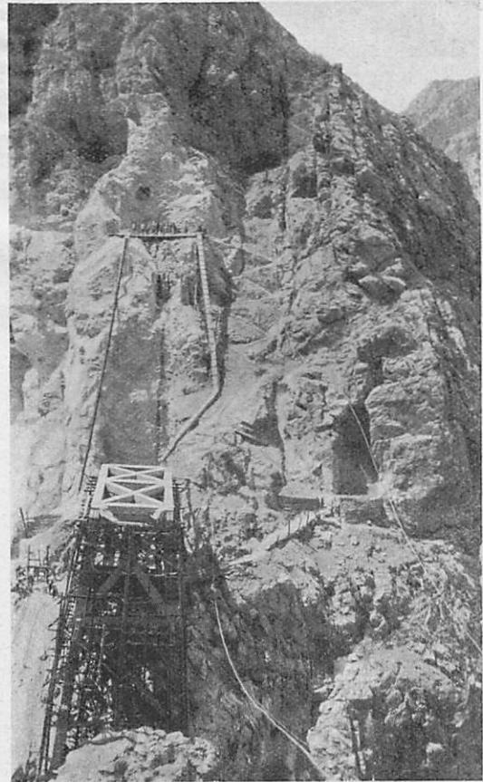
Bild 11. Bau des Untergerüsts in Eisenbeton für den Bogen von 66 m Spannweite, der bei km 219 die Vreskschlucht 110 m über dem Talboden überbrückt.
