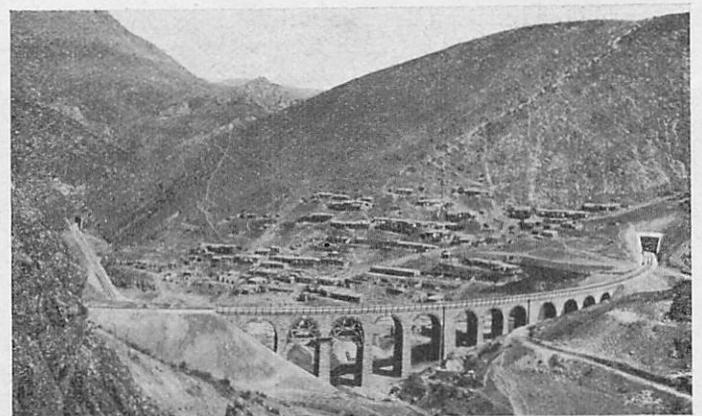
Bild 14. Teil der achterförmigen Entwicklung bei km 233 bis 236, links Ast zwischen km 234 bis 235, im Vordergrund Talkreuzung mit Viadukt bei km 236.
