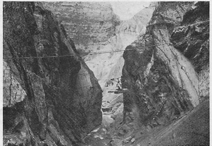
Bild 25. Im Cañon Nr. 4. Die Bahn läuft links im Tunnel. Bedienung des Tunnelfensters (links unten) durch eine Seilbahn. Die Preßluftleitung ist an einem Seil aufgehängt. Rechts oben Dienststraße und Kompressorenhaus.
