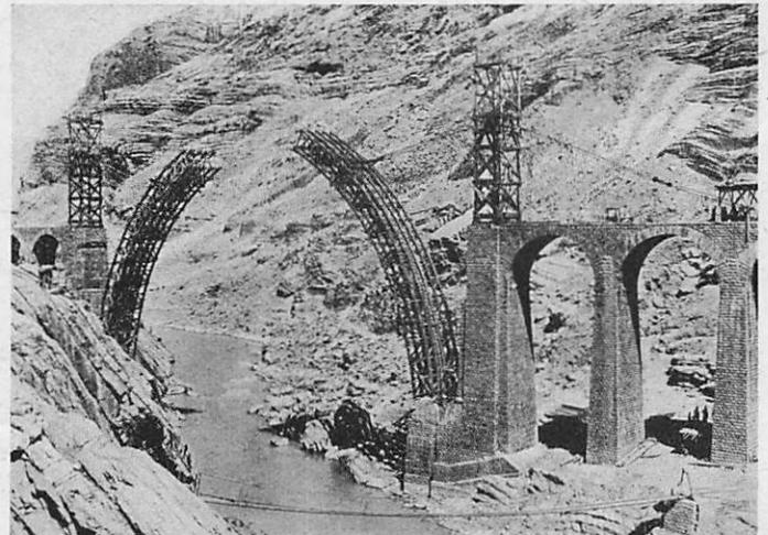
Bild 22. Bogenbrücke in Haustein bei km 1044, Hauptöffnung 66 m lichte Weite. Das Lehrgerüst ist als Dreiecksfachwerksbogen in Holz hergestellt. Das Bild zeigt die beiden Lehrgerüsthälften fertig zum Niederlassen für den Scheitelschluß.
