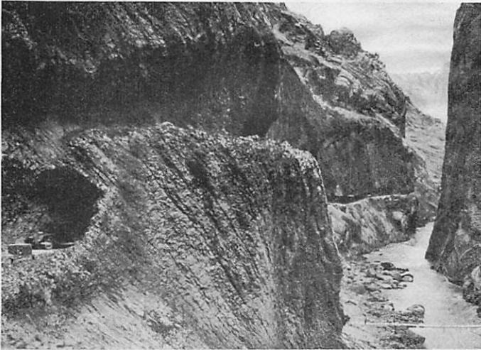
Bild 26. Dienststraße im Cañon Nr. 4. Die Straße für Kraftwagen läuft links in einem kleinen Tunnel, oberhalb der Kamelweg, der an dieser Stelle wegen ungünstiger Neigungs- und Richtungsverhältnisse verlassen wurde.
