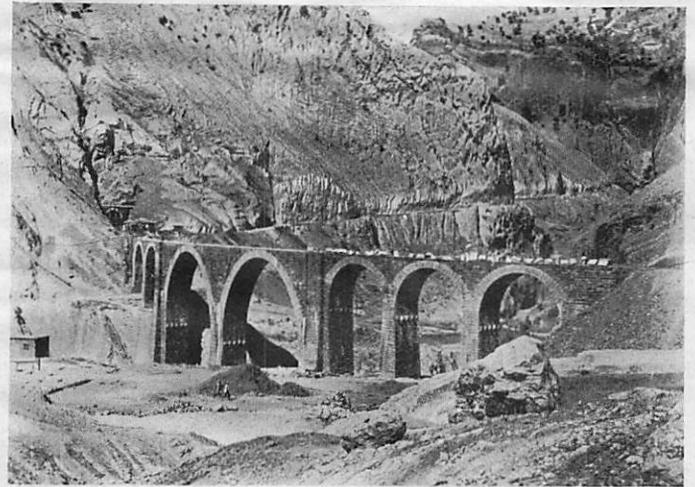
Bild 21. Überquerung eines Seitentales mit einem Viadukt (Hauptöffnungen  $2 \times 30$  m lichte Weite) mit Eingang ins Cañon Nr. 8. Im Hintergrund die Dienststraße in die Felsen eingehauen.
