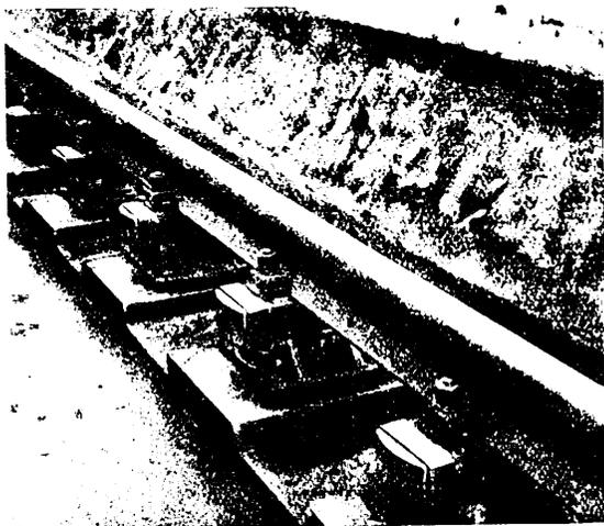
Abb. 9. Schienenpuffer auf einer Eisenbetonbrücke. Teilansicht.
