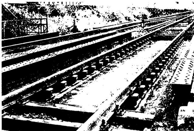
Abb. 6. Schienenpuffer auf einer Stahlbrücke. Gesamtansicht.
