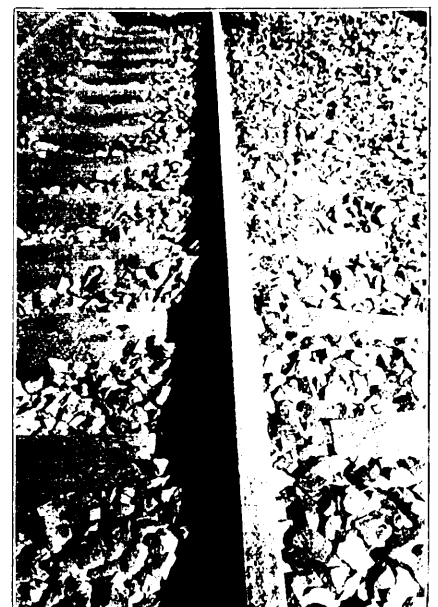
Abb. 3. Riffelbildung seitlich, links und rechts der Lauffläche.
