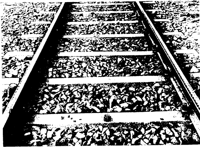
Abb. 14. Riffelbildung auf beiden Schienen.
