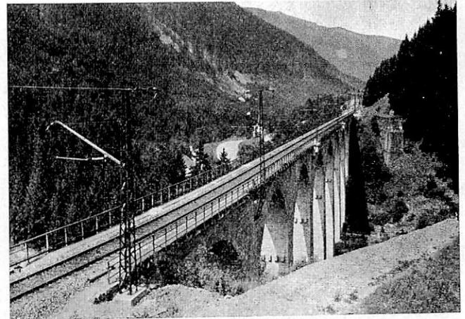
Abb. 11. Anklammermaste an der Ravennabrücke
