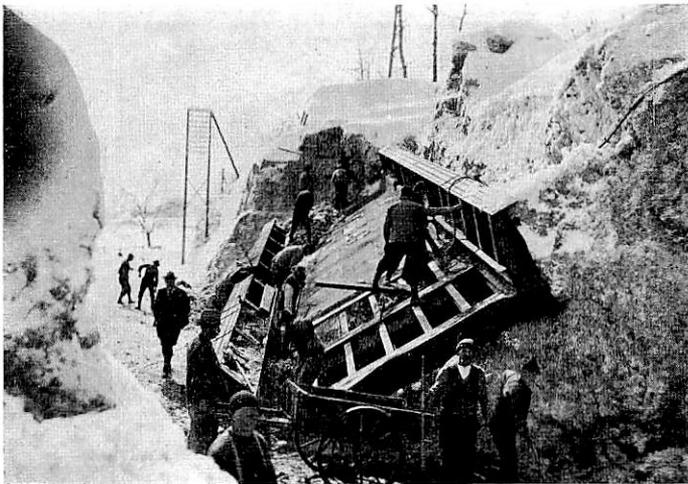
Abb. 13. Brienerseebahn. Grundlawine beim Minacherligaben-Verschobener Überbau.
