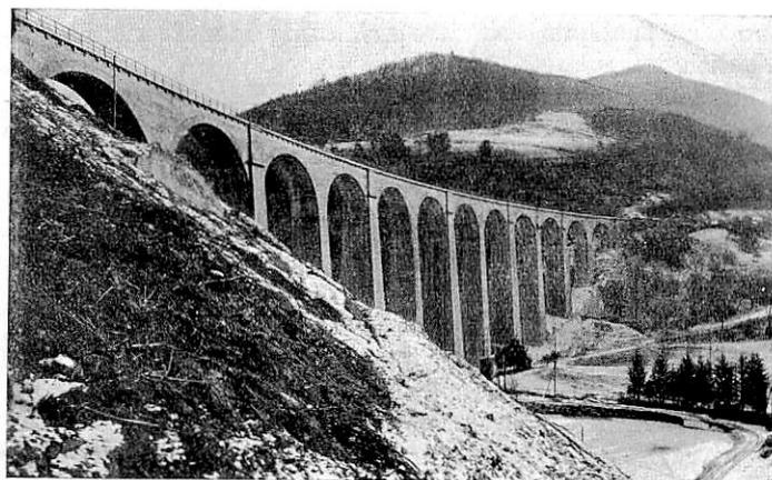
Abb. 20. Viadukt bei St. Ursanne, umgebauter Zustand unter Verwendung der alten Pfeiler und Widerlager; Einbau je eines neuen Pfeilers in jeder alten Öffnung.
