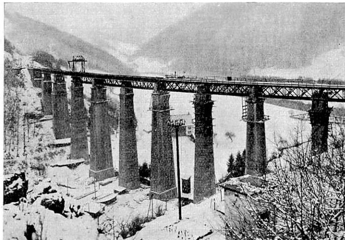
Abb. 19. Viadukt bei St. Ursanne, mit den drei Umbauzuständen, umfassend je drei Öffnungen (ohne Betriebsunterbrechung).
