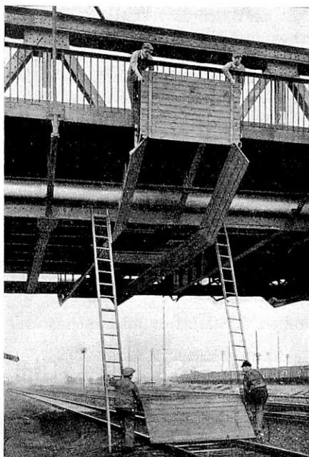
Abb. 3 c. Zwei Mann oben schieben eine Tafel 4 des Schirmes ein. Zwei Mann unten schaffen eine Tafel 4 nach oben, um sie durch die Schlitze am Knick einzuschieben.
