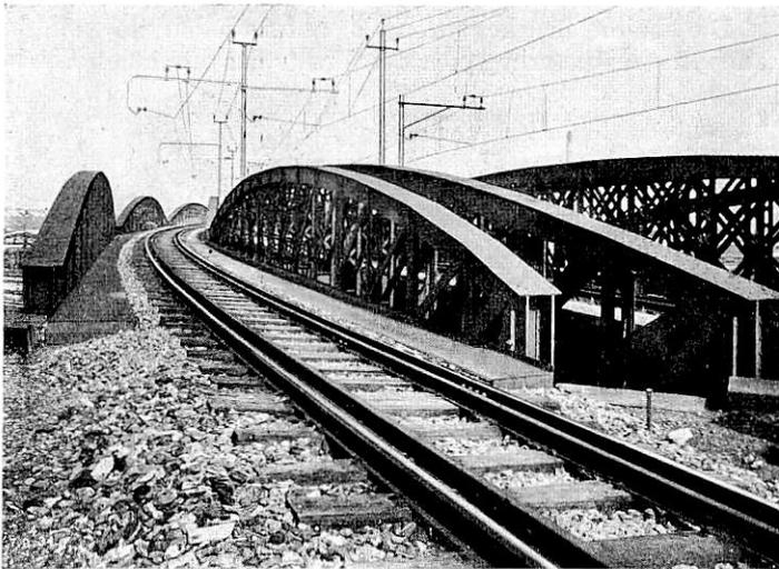
Abb. 7. Brücken über den Güterbahnhof in Zürich mit durchgehendem Schotterbett.
