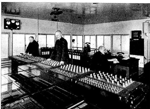
Abb. 5. Vierreihenstellwerk (Befehlsstellwerk).
