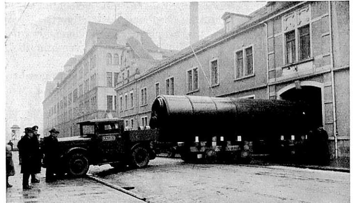
Abb. 5. Beförderung eines Kessels von 20 t Gewicht und 12 m Länge von dem Fabrikgebäude der Vereinigten Kugellagerfabriken (Fichtel und Sachs) zum Bahnhof Schweinfurt.
