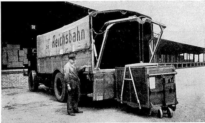
Abb. 3. Ladeschwinge für Behälterverladung.
