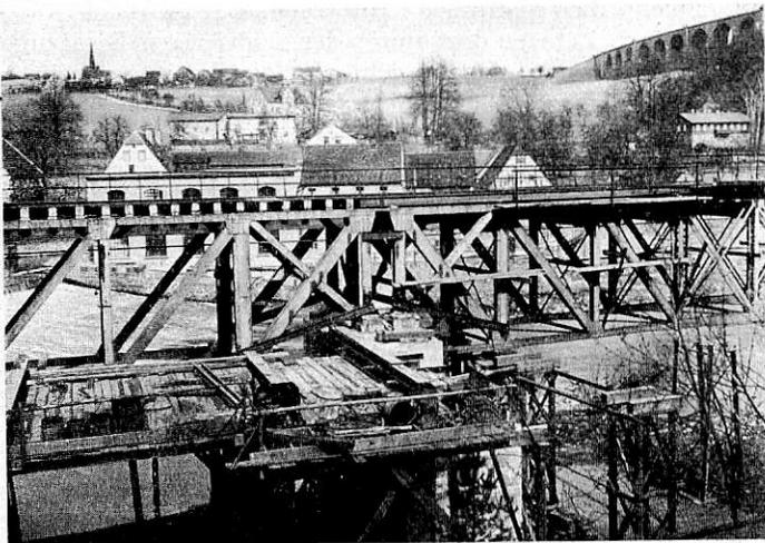
Abb. 1. Auflagerbank am Pfeiler und Sicherung der Endpfosten der alten Gleisträger.
