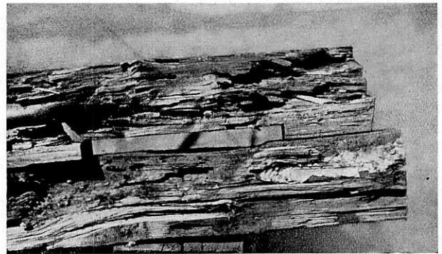
Abb. 6. Unter-Purkersdorf, erkrankte Schwellenlager.
