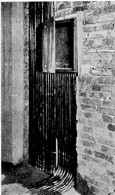
Abb. 7. Stockwerksverteiler.
