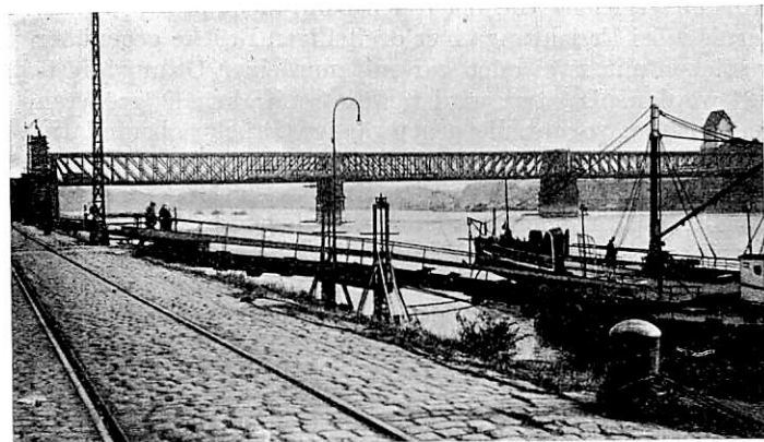
Abb. 4. Eisenbahn- u. Straßenbrücke zwischen Ludwigshafen u. Mannheim.
