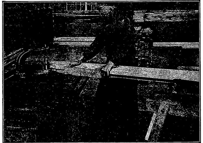
Abb. 2. Bearbeitung der Holzrungen auf der Fräse.
