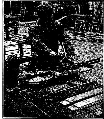
Abb. 6. Zapfenschnitten mittels Schlitzscheibe.
