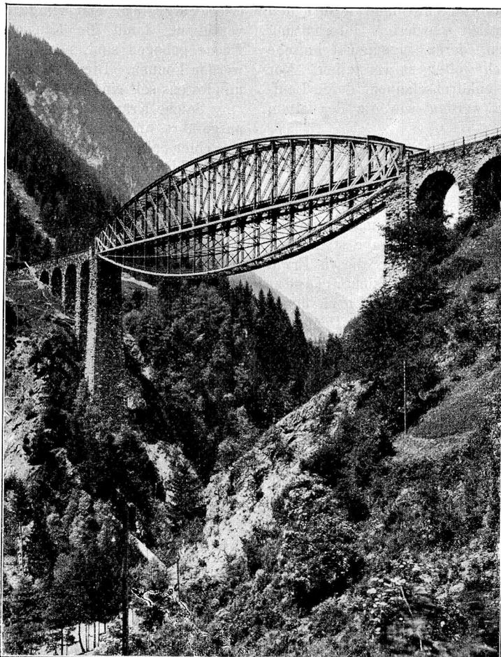
Abb. 4. Trisannabrücke. Tragwerk nach der Verstärkung.
