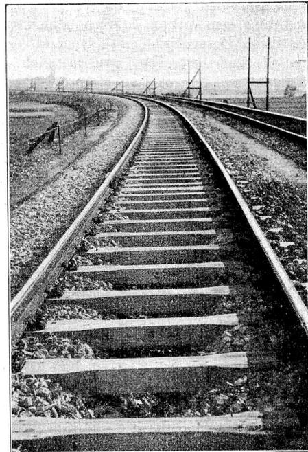
Abb. 2. Gleisverfüllung bei Eisenbetonschwellen.
