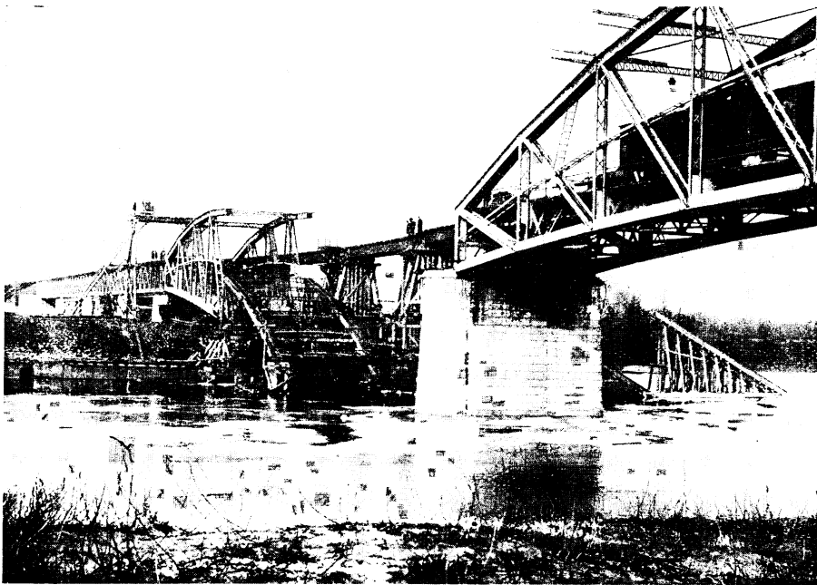
Abb. 2. Theißbrücke bei Szolnok. Zustand Anfang März 1921.
