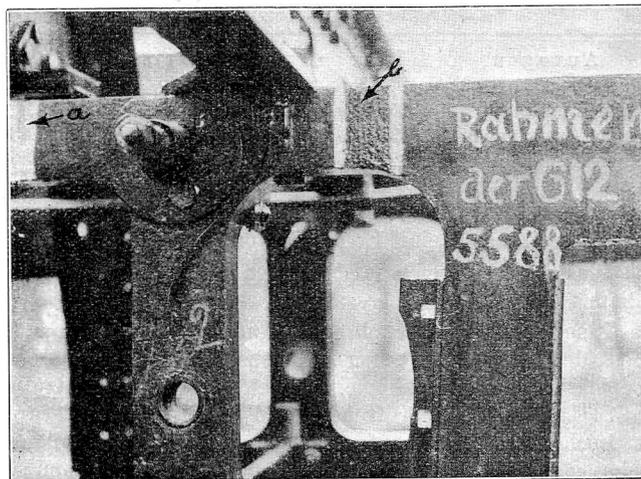
Gegenüber der früheren Ausbesserungsart dieser Schäden: Ausmeißeln, Nieten und Aufflicken von Blechstücken mittels Schrauben, bedeutet die jetzige Arbeitsart eine bedeutende Ersparnis an Zeit und Geld. Auch dem autogenen Schweißverfahren gegenüber erfordert das elektrische weniger Zeit und hat außerdem den Vorzug, daß es wegen der großen Schweißgeschwindigkeit übermäßige Erhitzung des Arbeitsstückes und
