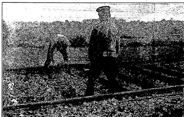
Abb. 6. Fertig gestopftes Gleis.
