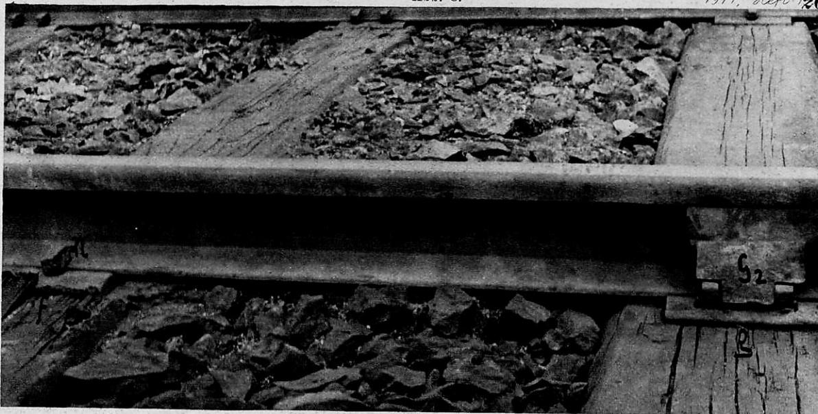
Abb. 6 und 7. Ungleiche Schonung der Schwellen unter Unterlegplatten mit und ohne Stöckel nach einem Jahre in Bogen von 370 m Halbmesser und 12‰ Gefälle. Zerstörung der Holzfasern gegenüber g, Eindrücken der Unterlegplatte und Lockerung des Nagels N durch angeklebte Messer ersichtlich. Stöckel G 5.
