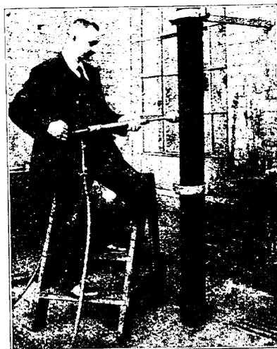
die Stelle der Stampferplatte ein balliger Körper aus Hartholz getreten, der vielleicht zweckmäßig durch einen solchen aus Eisen oder weichem Stahle ersetzt werden könnte.
