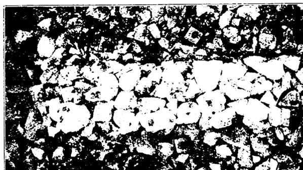
nahmen von Schwellenlagern aus Grobschotter unter eisernen Querschwellen stark befahrener Betriebsgleise des Verschiebeshofes Karlsruhe nach dem ersten Stopfen; sie zeigen ebenfalls die unvollkommene Ausbildung der Oberfläche des Lagerkörpers, die zahlreichen und großen Zwischenräume zwischen den Steinen und die Auflagerung des Schwellendeckels auf überstehenden Steinen. In Textabb. 3 sind die Abdrücke der Schotter-
