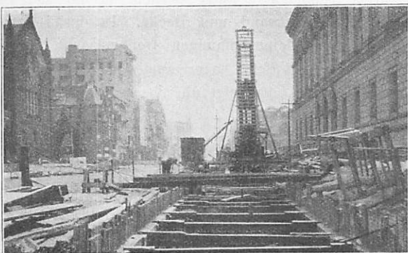
Abb. 31. Bau der Untergrundbahn in der Boylstonstraße in Boston. Rammen von Lackawanna-Spundwänden bei der öffentlichen Bibliothek.
