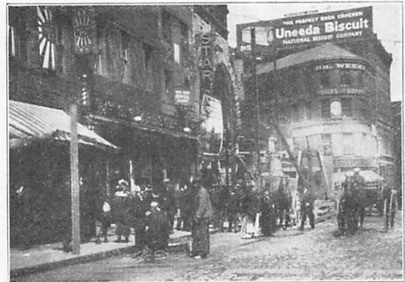
Abb. 33. Bau der Verlängerung des Ost-Boston-Tunnels. Ausführung der Tiefergründungsarbeiten an der Courtstraße.
