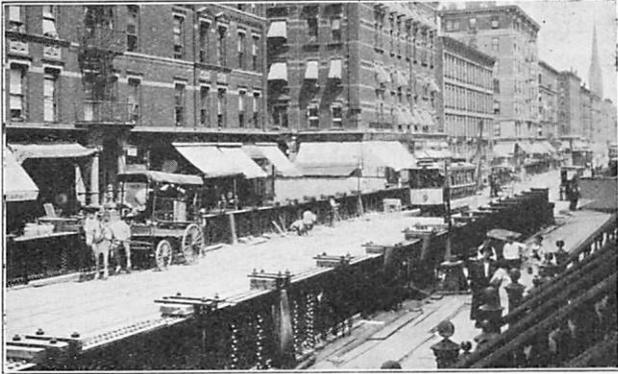
Im Tieftunnel wird der Felsausbruch auf Rollbahnen zu den in den Querstraßen angeordneten Schächten gefahren, wo die eisernen Tröge von Kränen gehoben und auf Pferde- oder Kraft-Fuhrwerk gesetzt werden (Textabb. 3).
